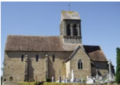
4 SAINT-CÉNERI-LE-GÉREI, ÉGLISE, élévation du côté sud.
