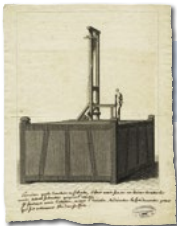
1 LA GUILLOTINE À ALENÇON. La décision de l'installer est prise en septembre 1792.
