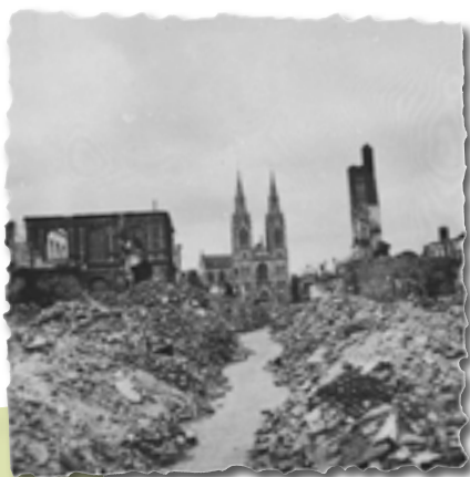
1 DESTRUCTIONS À VIMOUTIERS, SITE HUMAINEMENT LE PLUS MEURTRI DU DÉPARTEMENT. Le 14 juin, 200 habitants sont touchés à mort. À gauche de la photo, ce qui reste de la halle au beurre.
